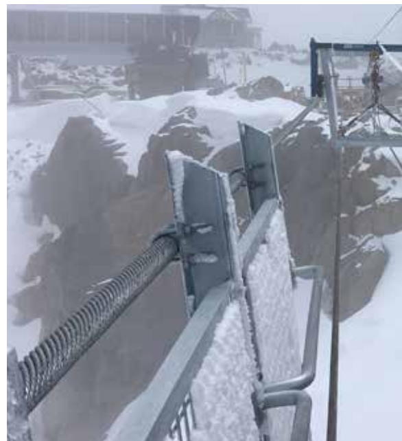
Installation à mi-chemin, juin 2018.
