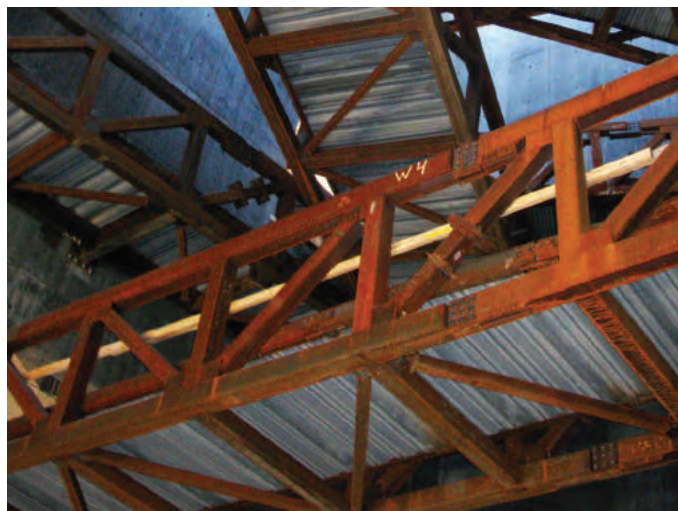
Figure 6 : Rampes du Hall de l'espoir avant l'installation du revêtement de pierre
