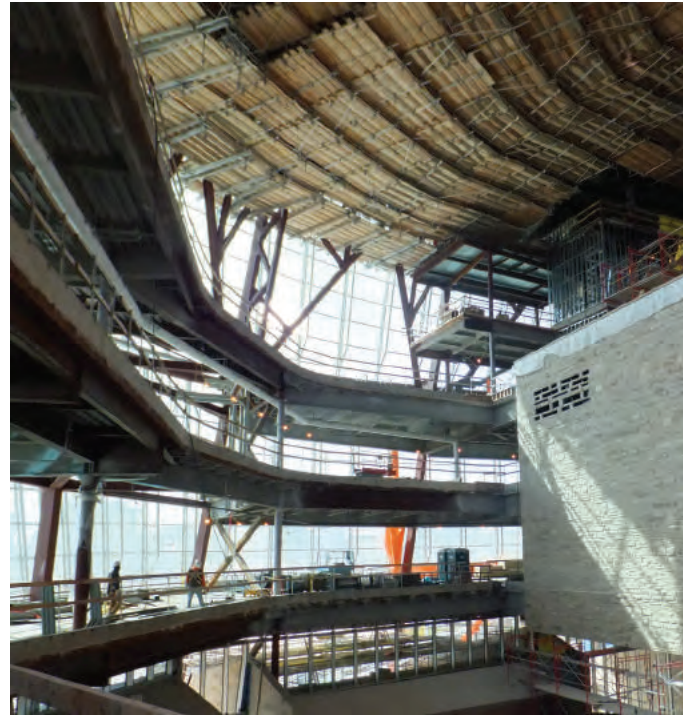
Figure 4 : Atrium du Nuage entre les bureaux et la Montagne, surplombant le Jardin de la contemplation
