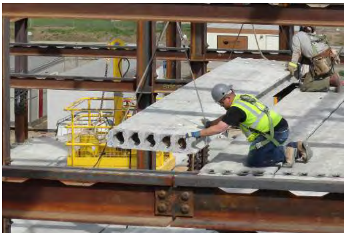
Figure 4 : Installation des dalles alvéolées.
