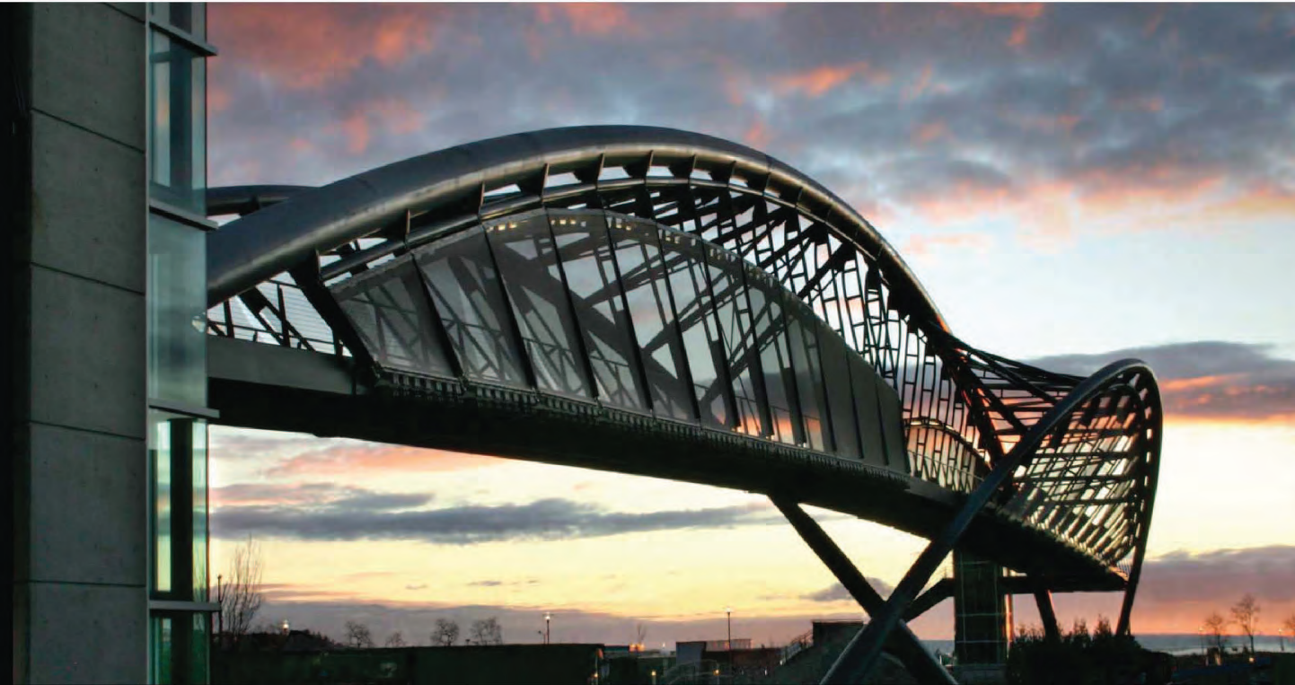
Pont hélicoïdal de Seattle Washington – 36 po (O.D.) x 1,25 po (paroi) et 24 po (O.D.) x 1 po (paroi) avec cintrage en hélice selon plusieurs rayons de courbure
