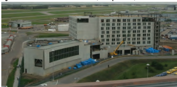
Figure 2 : État d'avancement des travaux (début juin 2012)
