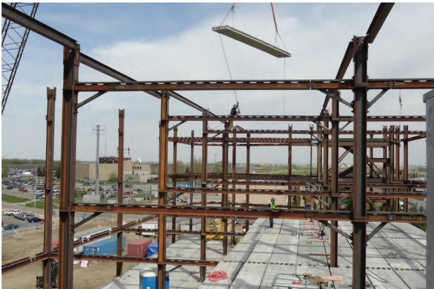
Figure 1 : Montage de l'aile Est de l'hôtel par les monteurs de charpentes métalliques
