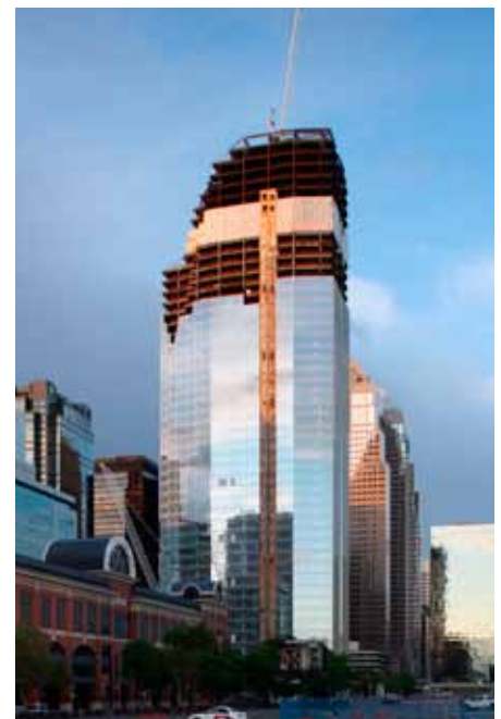
Coucher de soleil sur la tour juste avant la clôture du chantier
