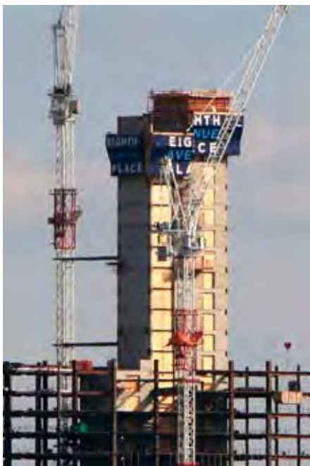
Progression régulière du noyau en béton et de la charpente en acier, à raison d'un étage par semaine
