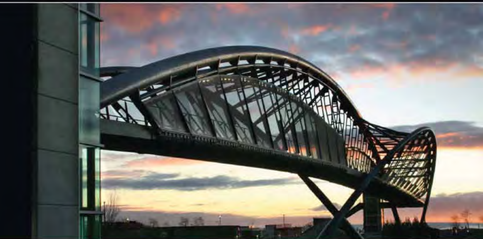
Pont hélicoïdal de Seattle Washington – 36 po (O.D.) x 1,25 po (paroi) et 24 po (O.D.) x 1 po (paroi) avec cintrage en hélice selon plusieurs rayons de courbure
