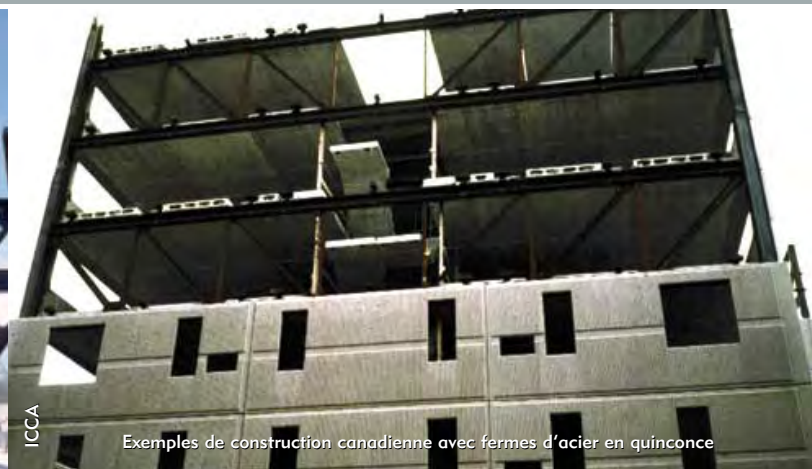
Exemples de construction canadienne avec fermes d'acier en quinconce
