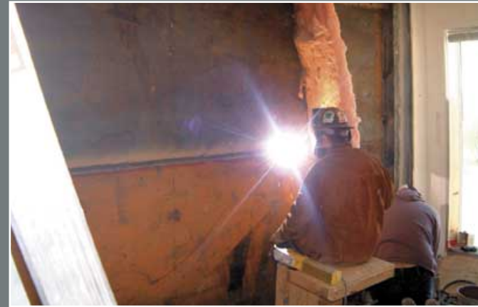
2) Ancrer, boulonner et souder le tout.
