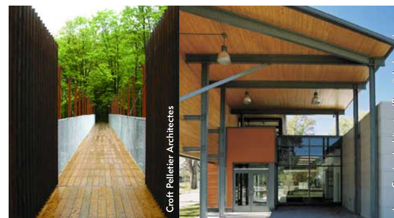
L'acier comme système structural principal (poutres et poteaux) et le bois comme système secondaire (revêtement, plancher)
