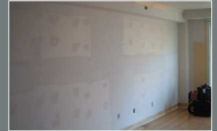
4) Et fermer avec les panneaux de gypse!
