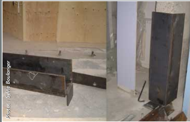
1) Apporter en pièces les éléments nécessaires pour construire le refend: collets en U, profilés W, cornières et plaques.
