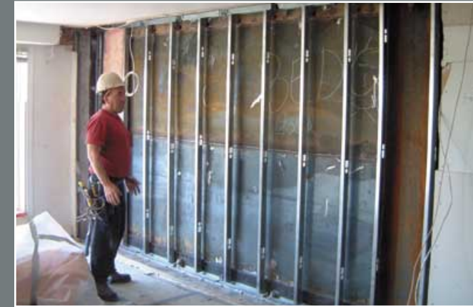
3) Replacer le colombage métallique et l'isolant.
